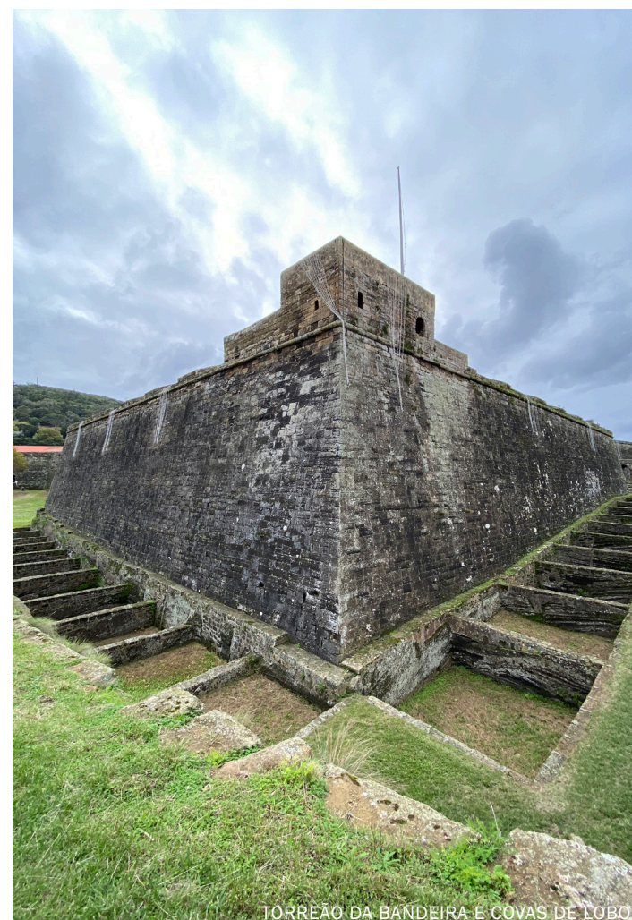
TORREÃO DA BANDEIRA E COVAS DE LOBO
